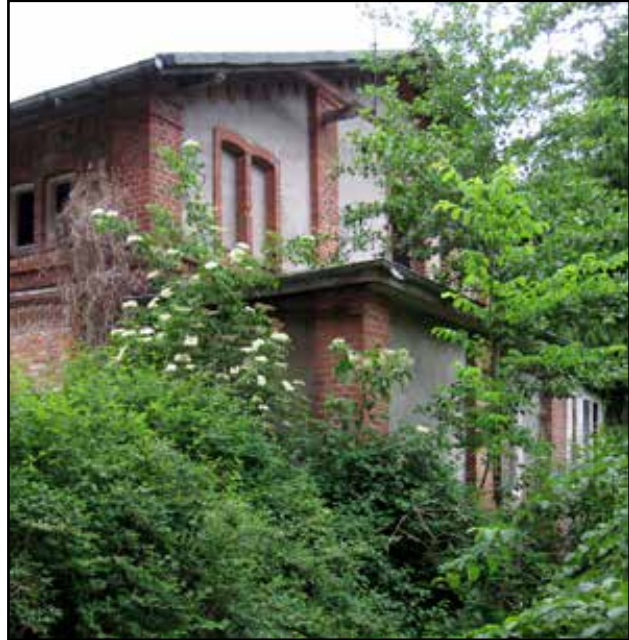
Abbildung 1: Mögliches Thema einer Kundschaft: Welche Geschichte hat das verfallene Fabrikgebäude in unserer Stadt?
